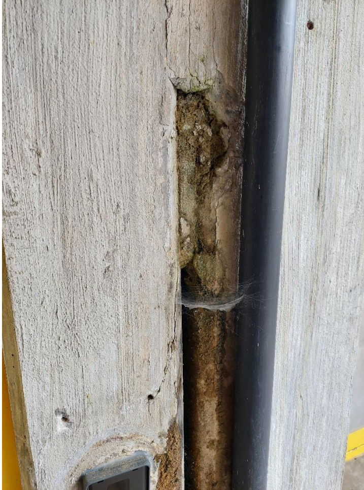
Photo n° 4 Joint endommagé
