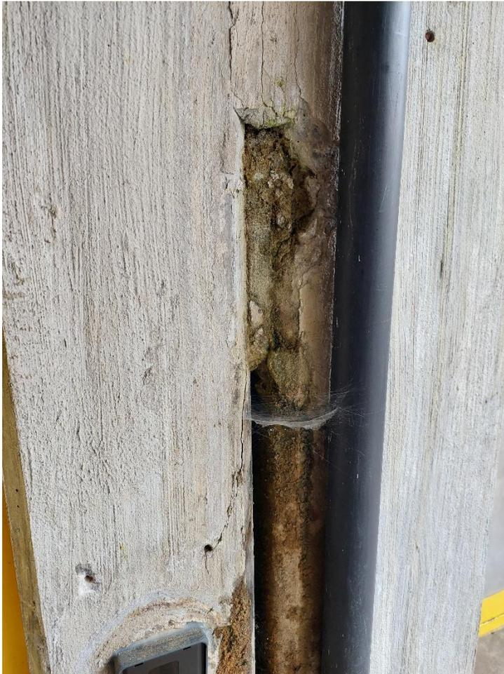
Bild 4 Beschädigte Fuge
