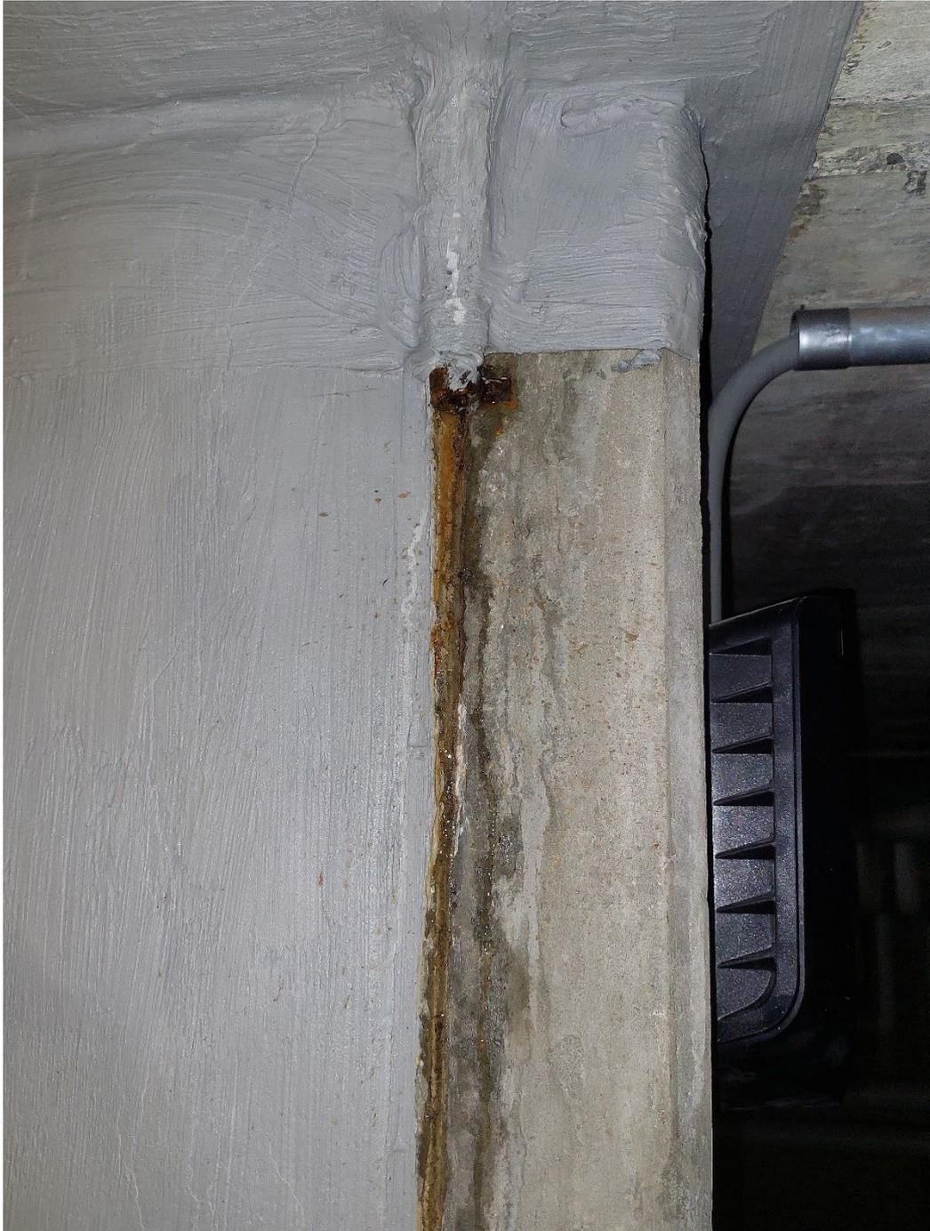
*Bild 8: Schadhafte Fuge*
