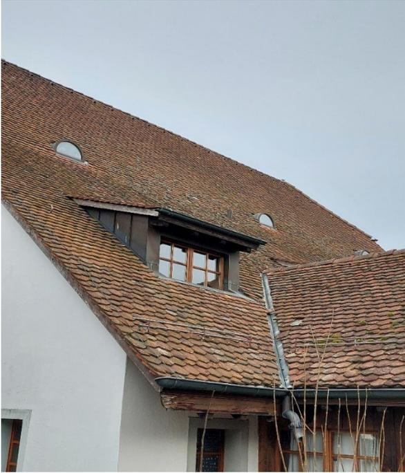
*Bild 1: Dach mit Biberschwanzziegeln*
