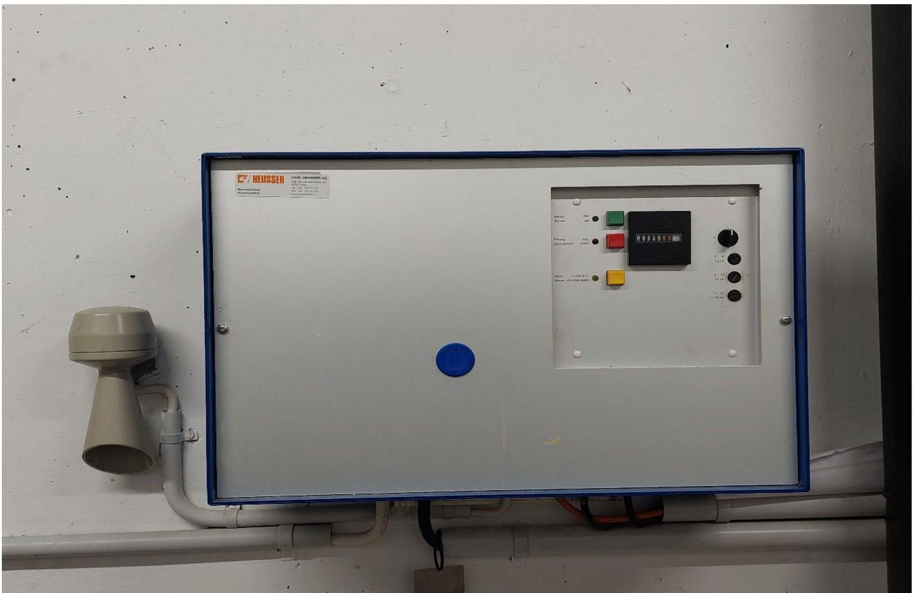
Bild 11: Steuerung Hebeanlage
