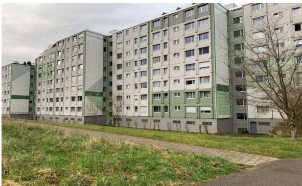
Abbildung: Gebäude 3 bis 6
